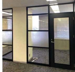
G-G-G-G/ランマガラス3段ブロックガラス
