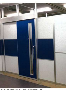
P-P-P-O/ランマオープン3段ブロック(パネル/パネル/パネル)
